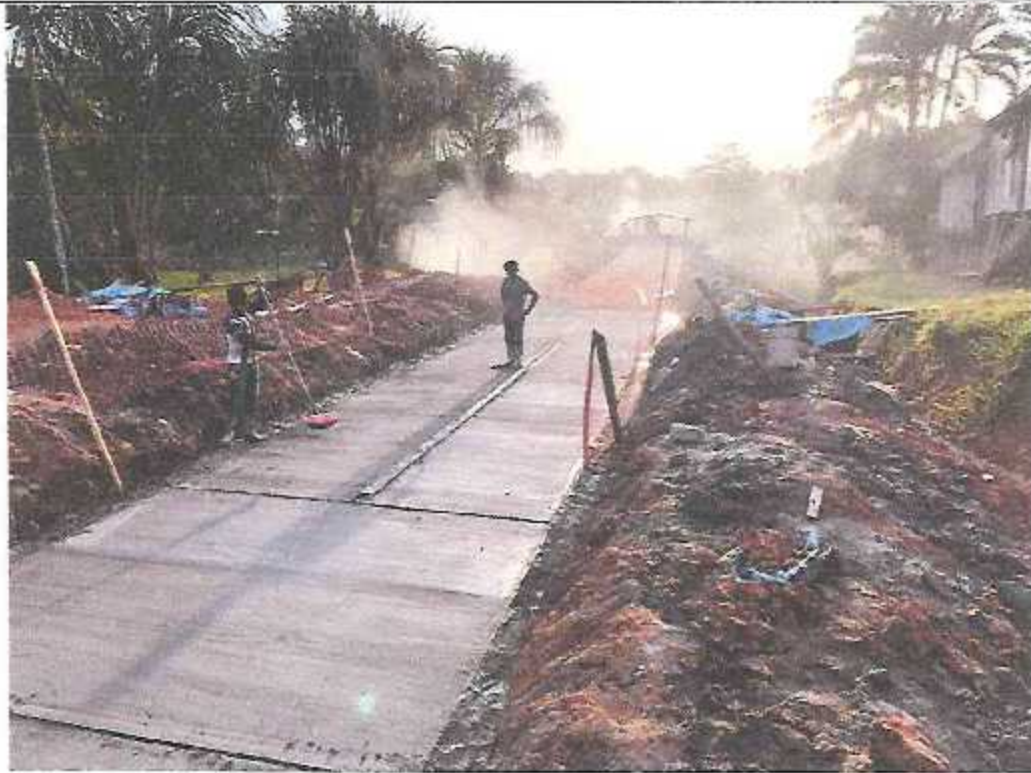
Imagen 3: Frotachado de losa maciza del pavimento rígido.
