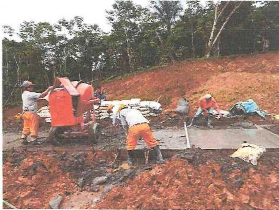
Imagen 1: Vaciado de mortero mortero f'c=210 kg/cm2 para losa de rodadura de la vía.
