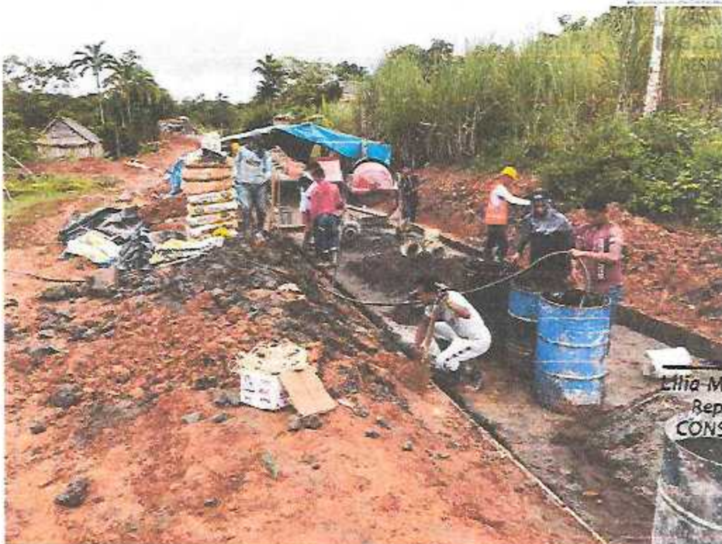
Imagen 4: Actividades de vaciado de mortero f'c=210 \text{ kg/cm}^2 para losa de rodadura de la vía.
