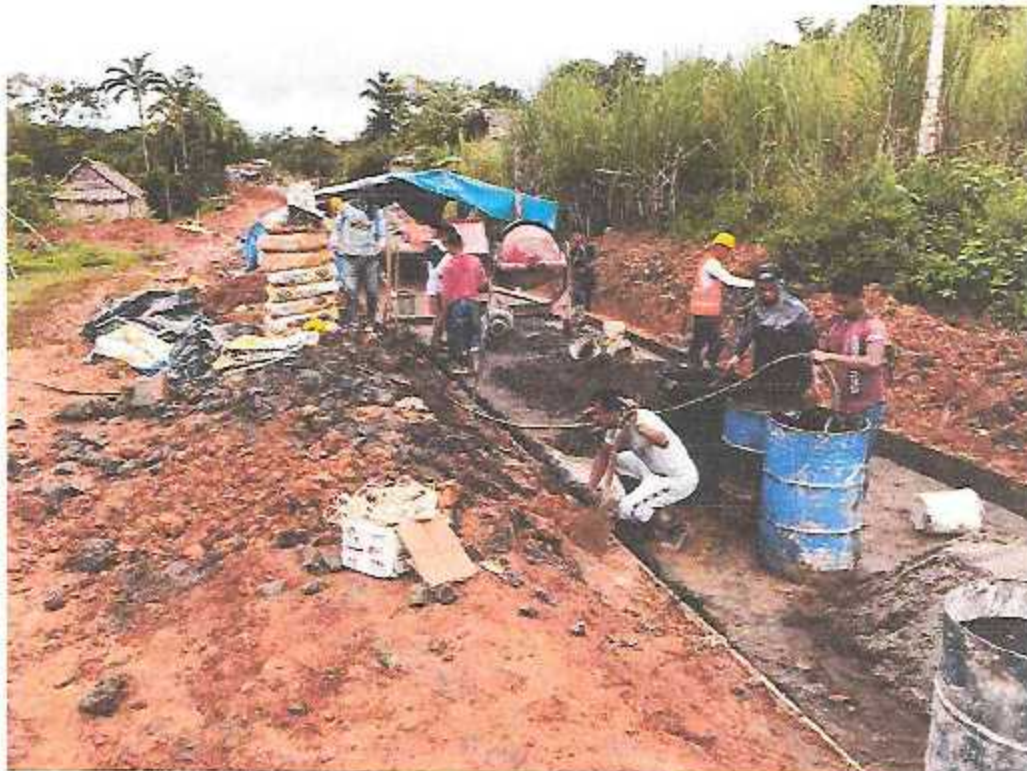
Imagen 4: Actividades de vaciado de mortero f'c=210 kg/cm 2 para losa de rodadura de la v.a.
