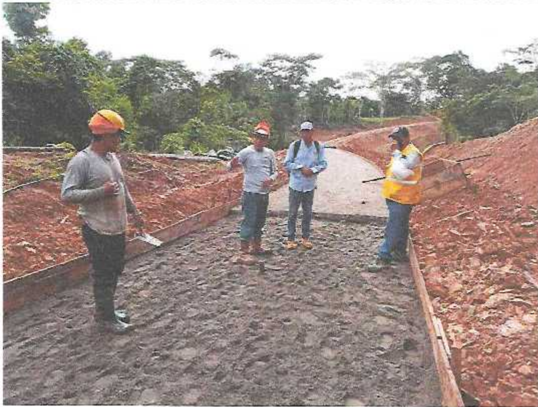
Imagen 9: Trabajos de Anticontaminante, material granular A-3
