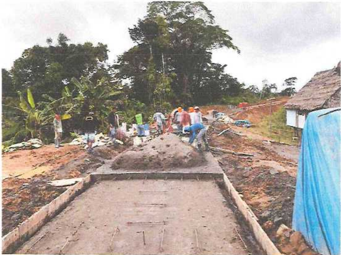
Imagen 5: Actividades de vaciado de mortero f'c=210 kg/cm 2 para losa de rodadura de la vía.
