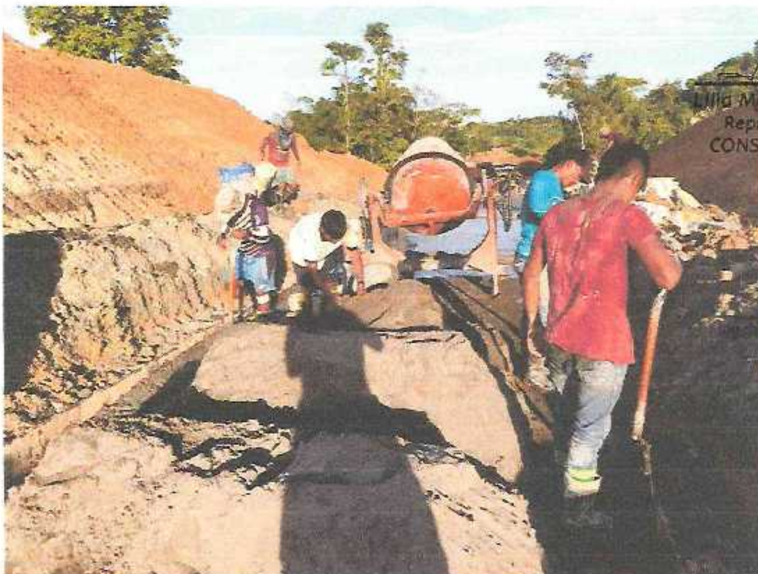
Imagen 6: Vaciado de masas de mortero f'c=210 kg/cm 2 para la losa de rodadura
