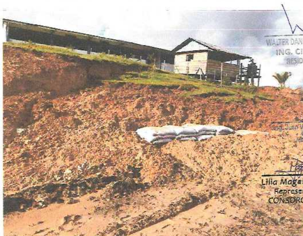
Imagen 8: Colocación de muro de bolsacreto en zona de deslizamiento.
