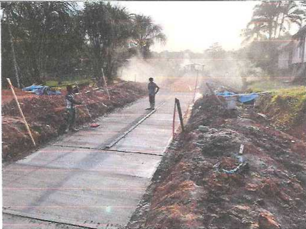
Imagen 3: Frotachado de losa maciza del pavimento rígido.
