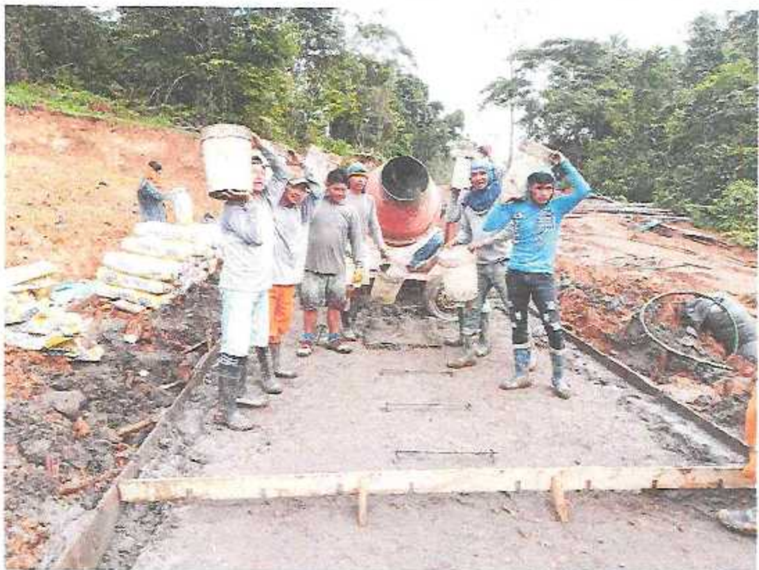
Imagen 6: Vaciado de líneas de mortero f'c=210 kg/cm 2 para la losa de rodadura
