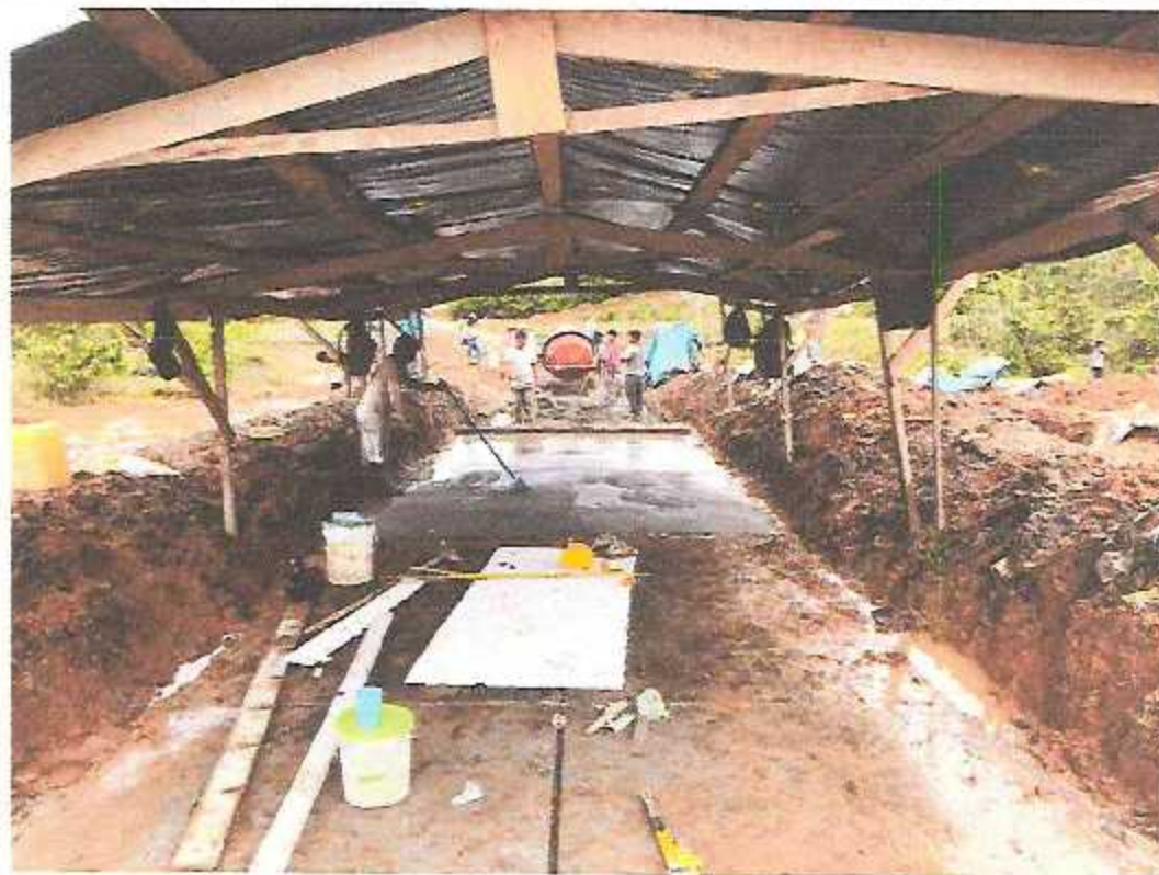
Imagen 7: Trabajos de curado de losa de rodadura con material de préstamo
