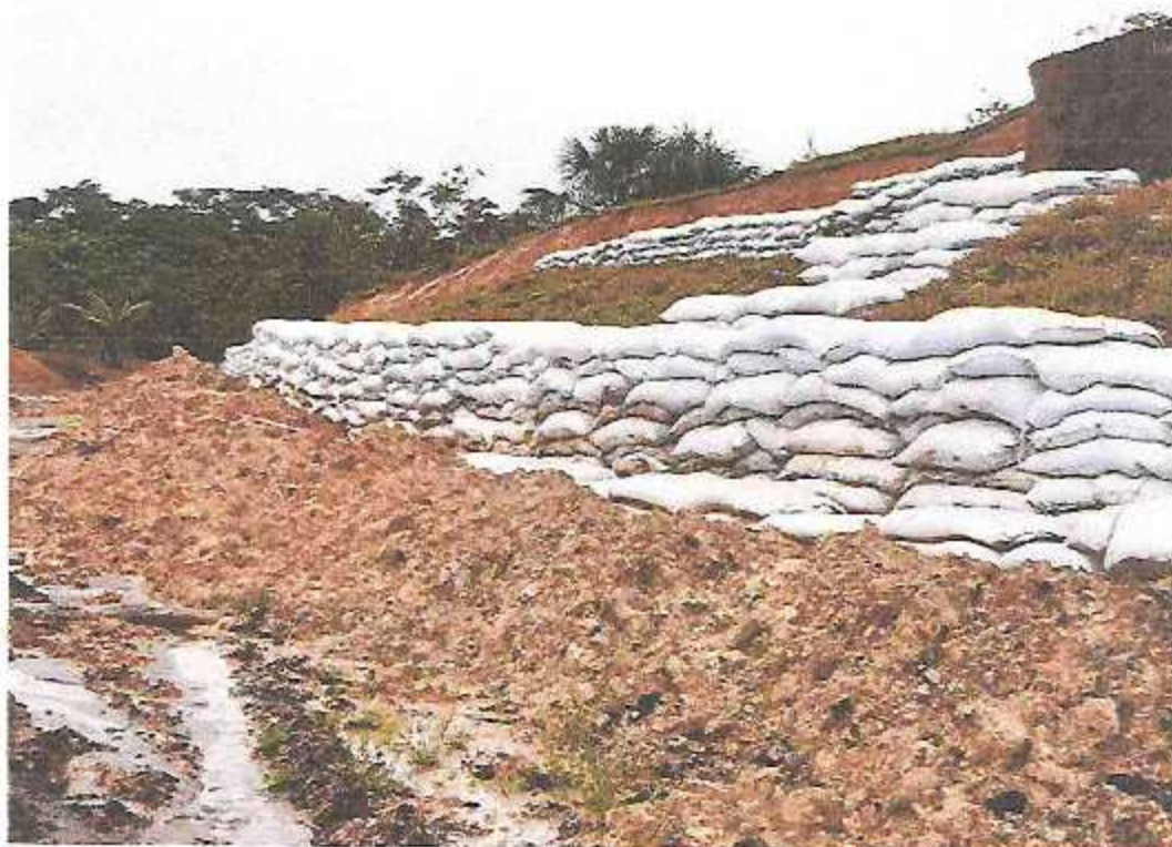
Imagen 8: Colocación de muro de bolsacreto en zona de deslizamiento.
